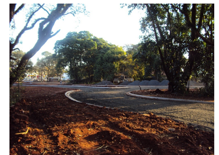
Figura 5 – Fotografia da construção da nova entrada do CENA .
